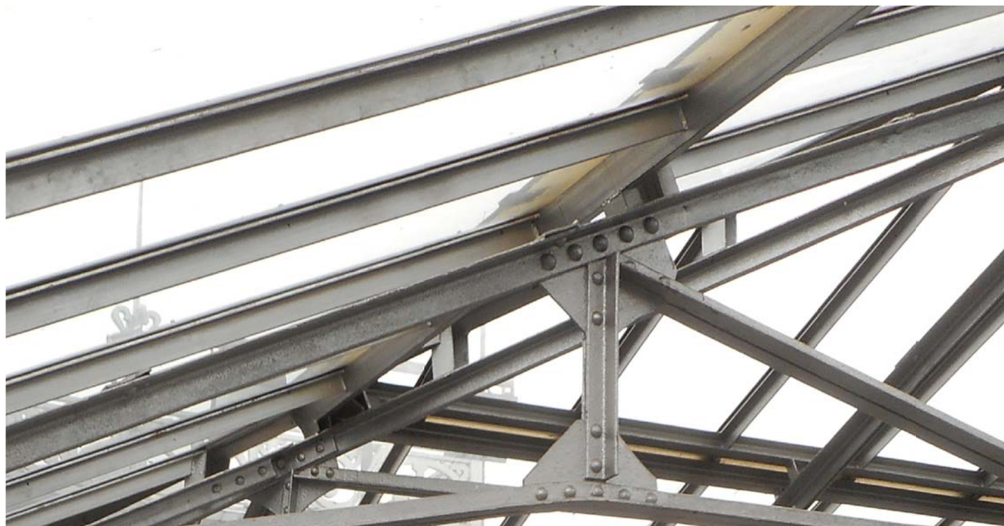
Vista inferior del solape entre vidrios decalados
